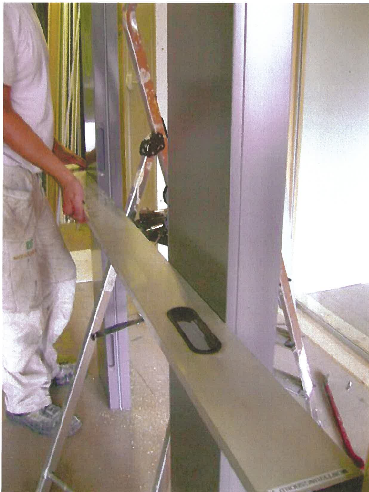
Justering av sidepaneler parallelt
