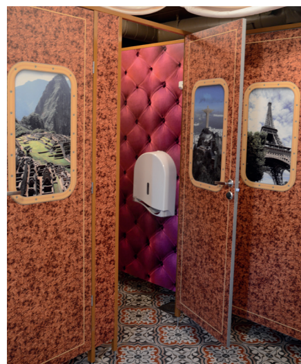
LTT 24 mm trykklaminat, brentmalt aluminiumsprofilramme, Borgbacken bandal
